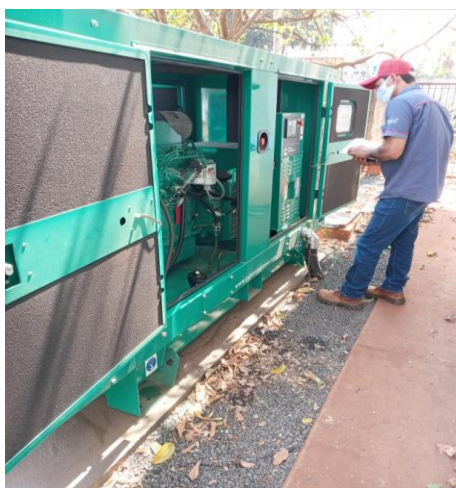
Figura 7. Manutenção gerador
