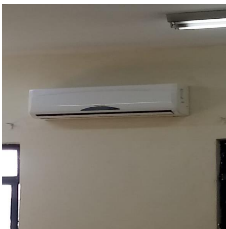
Figura 9. Instalação de Aparelho de ar condicionado
