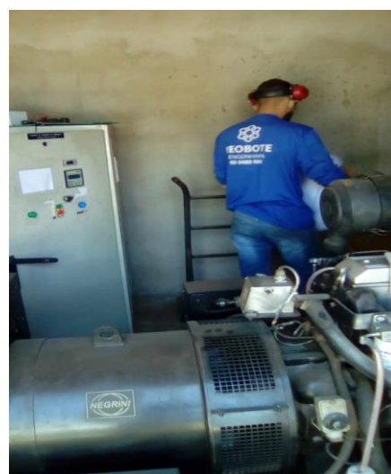
Figura 4. Manutenção Gerador - REOBOTE
