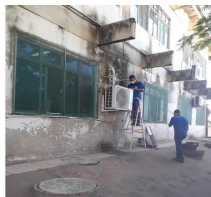
Figura 2. Manutenção corretiva ar condicionado Fracionamento
